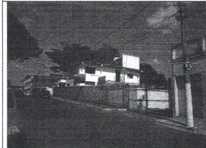
Estação de Tratamento de água Localizado: Rua Barão de Congonhas nº230 Bairro Matriz
