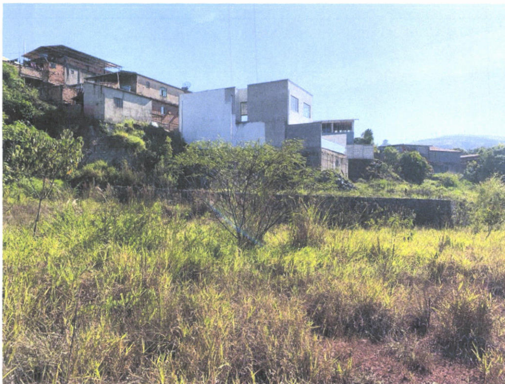
Imagem 05 – Muro de contenção existente
