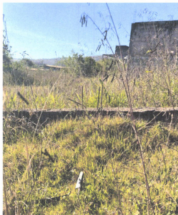
Imagem 04 – Muro divisório com bloco de concreto
