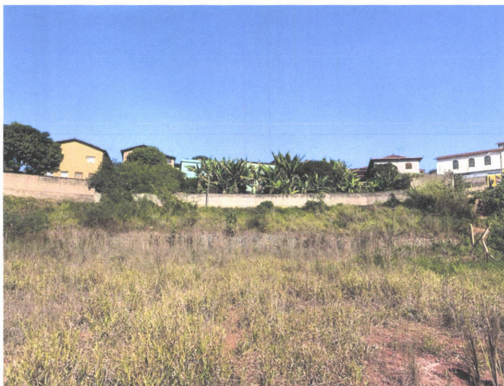
Imagem 02 – Muro de contenção existente
