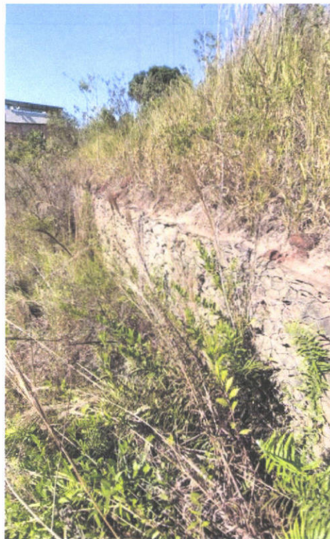
Imagem 03 – Muro de contenção existente
