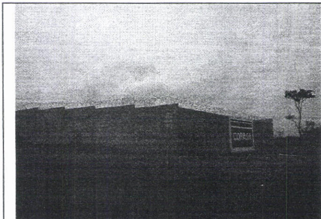
Reservatório Deneru Localizado: Av. Contorno Norte s/n
