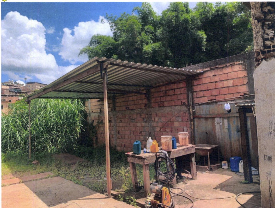
Imagem 04- Vista da coberta aos fundos do imóvel.
