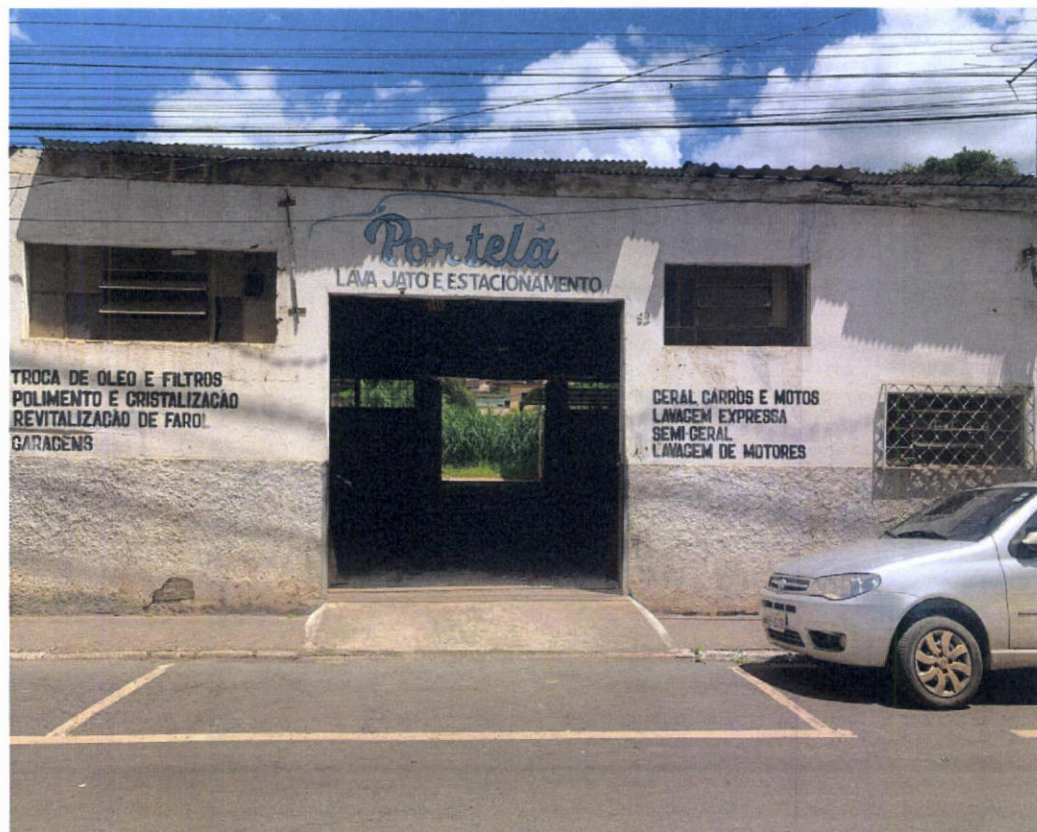
Imagem 02- Fachada do imóvel.
