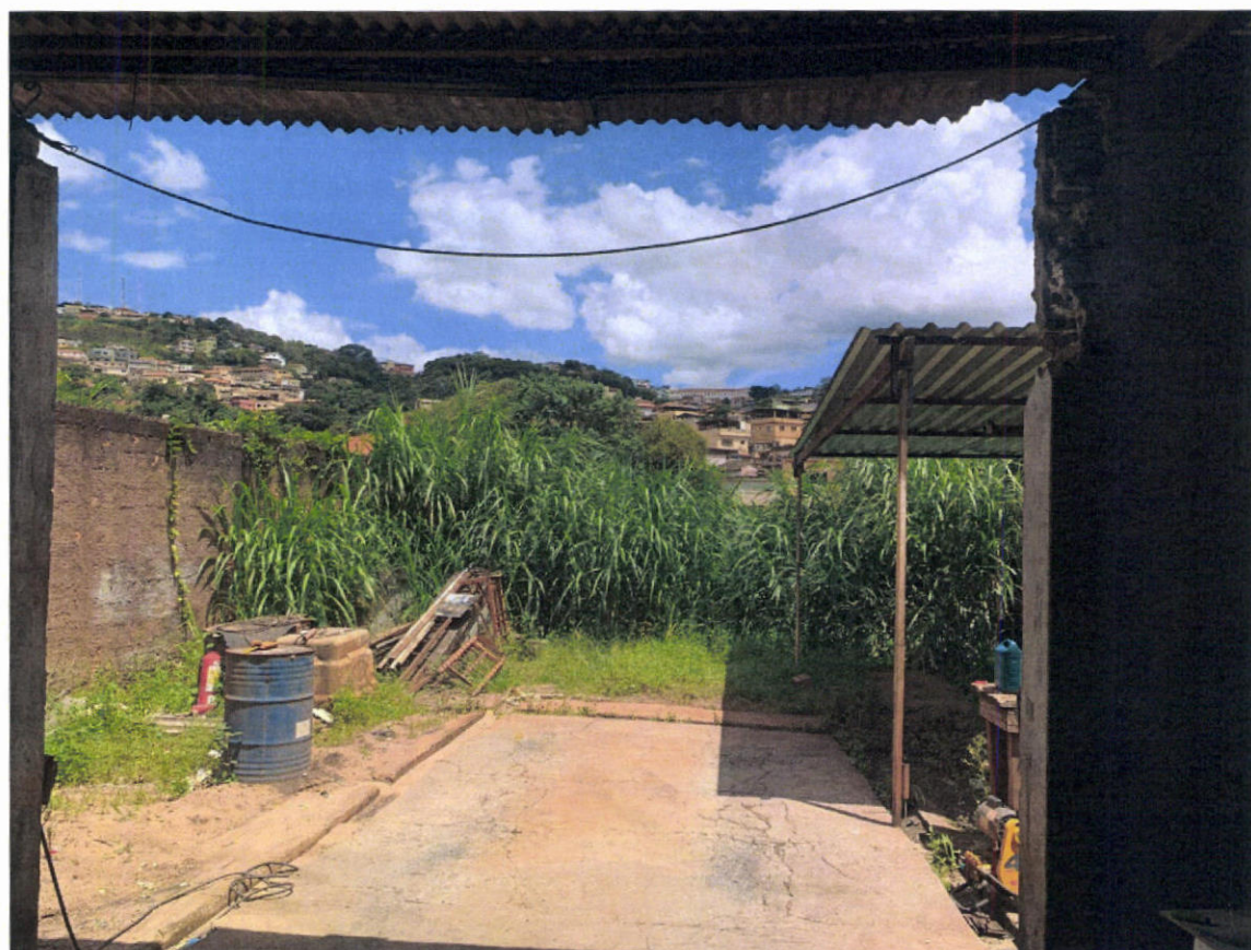
Imagem 05- Vista dos fundos do imóvel.
