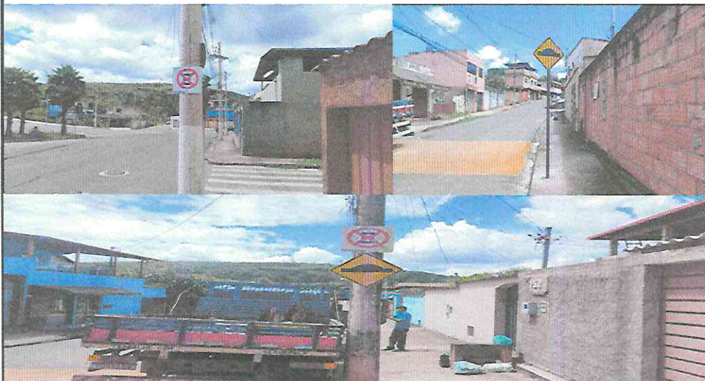
Instalação de Placa e Suporte - Av. Mauá
