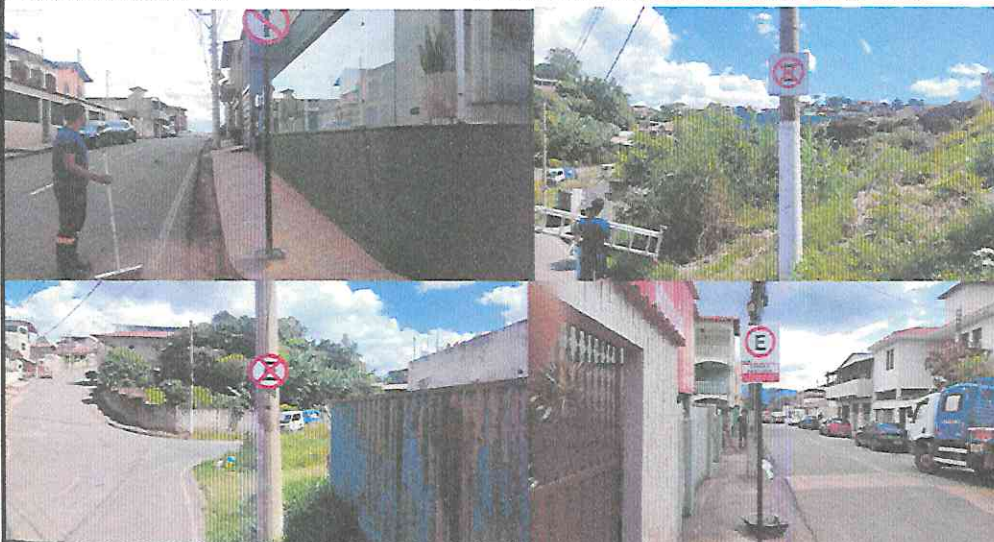
Instalação de Placa e Suporte - Rua Ideal
