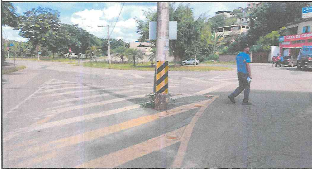
Instalação de Placa - Rua Palmas
