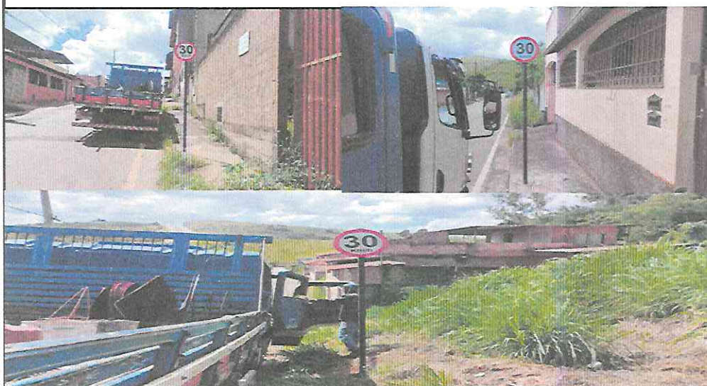
Instalação de Placa e Suporte - Rua Jair Elias
