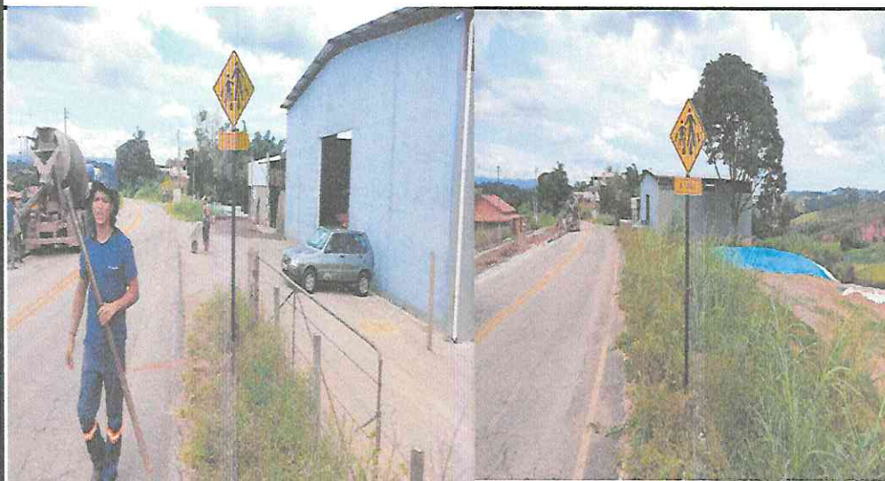
Instalação de Placa e Suporte - Rua Maria Alacoque/Alto Maranhão
