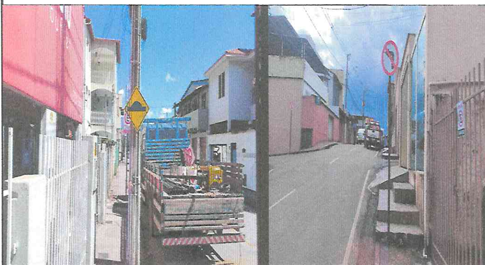
Instalação de Placa e Suporte - Rua Ideal
