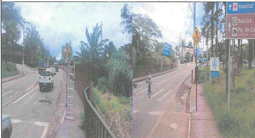
Instalação de Placa e Suporte - AV. Juscelino Kubitschek
