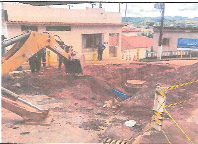
EXECUÇÃO DE ESCAVAÇÃO - AVENIDA BIAS FORTES - BASILICA
