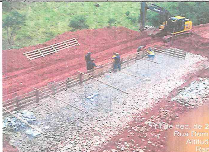
EXECUÇÃO DE MONTAGEM DE CAIXA DE GABIÃO - MG - 383 / ALTO MARANHÃO
