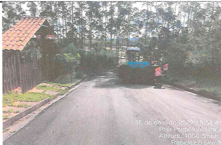
EXECUÇÃO DE CBUQ - BAIRRO CASA DE PEDRA
