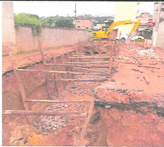
EXECUÇÃO DE REDE DE DRENAGEM E ESCORAMENTO - RUA ALFREDO GUERRA - PRAIA
