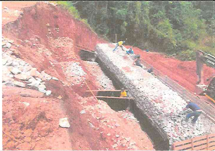
EXECUÇÃO DE MONTAGEM DE CAIXA DE GABIÃO E MANTA GEOTEXTIL - MG - 383 / ALTO MARANHÃO
