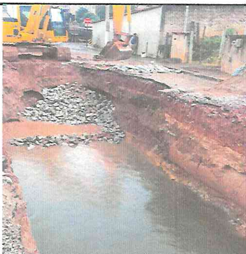
EXECUÇÃO DE ENROCAMENTO - RUA ALFREDO GUERRA - PRAIA
