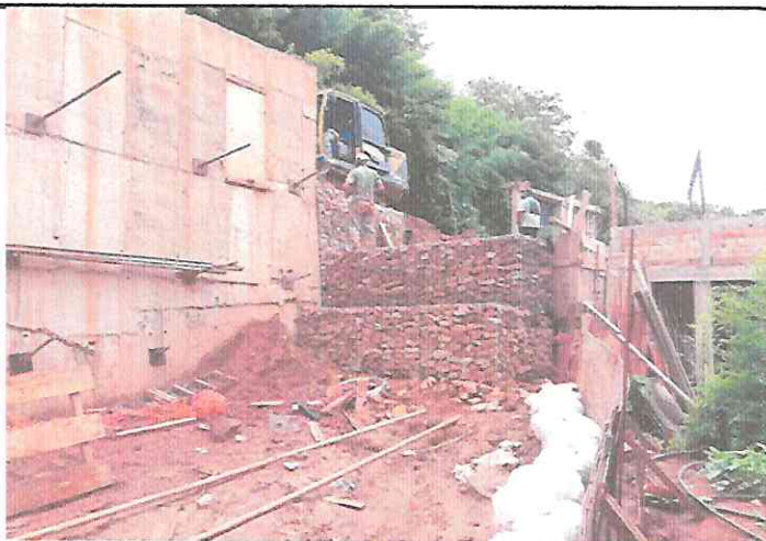
EXECUÇÃO DE MONTAGEM DE GABIÃO - RUA DA RECORDAÇÃO - VILA RICA
