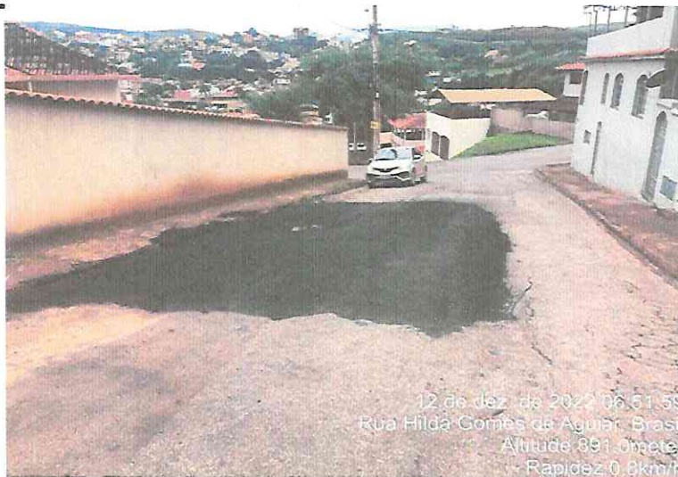
EXECUÇÃO DE OBRAS - RUA HILDA GOMES DE AGUIAR - BOA VISTA
