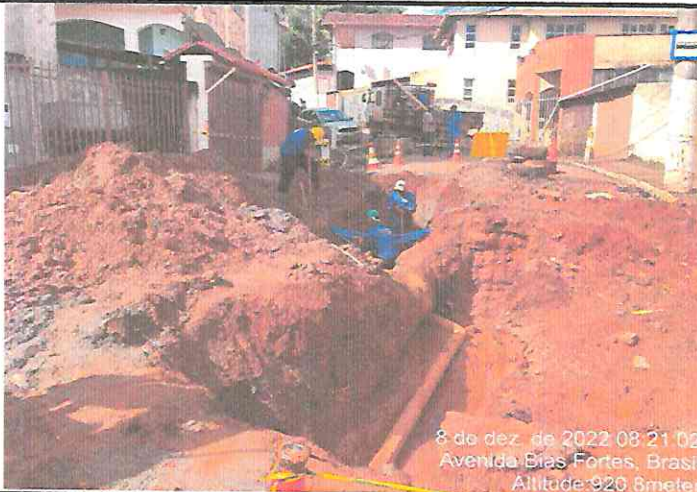
EXECUÇÃO DE REDE DE 600 MM - AVENIDA BIAS FORTES - BASILICA
