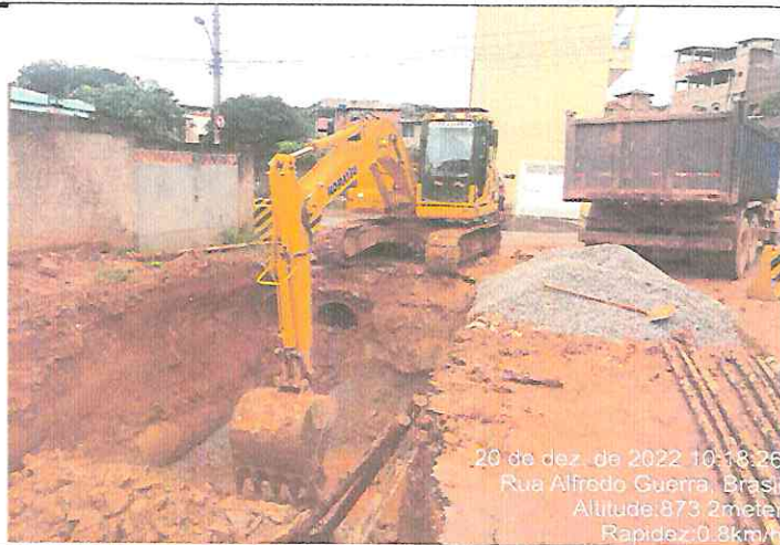
EXECUÇÃO DE ESCAVAÇÃO - RUA ALFREDO GUERRA - PRAIA
