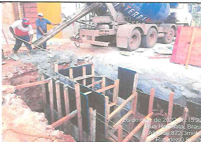
EXECUÇÃO DE CAIXA DE PASSAGEM - RUA ALFREDO GUERRA - PRAIA
