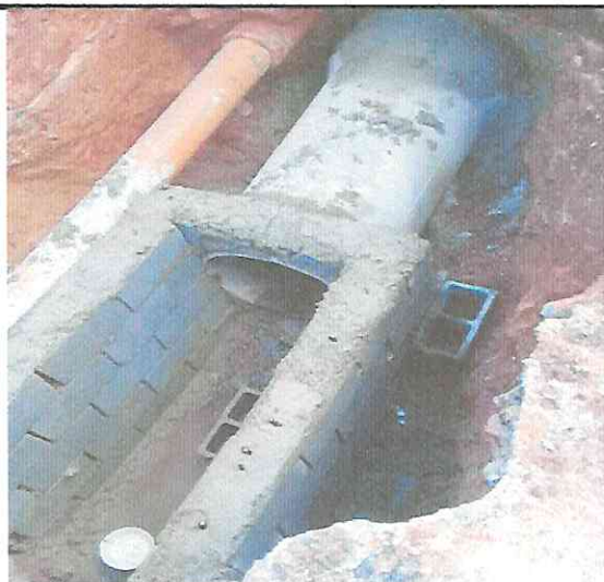
CAIXA DE PASSAGEM - RUA HILDA GOMES DE AGUIAR - BOA VISTA
