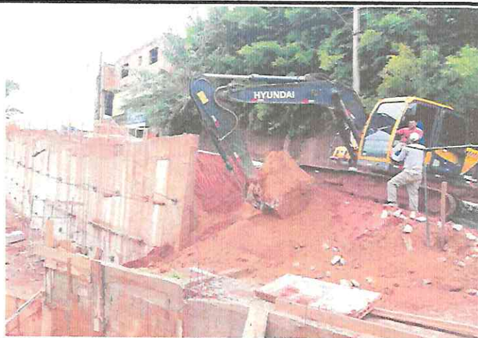
EXECUÇÃO DE ESCAVAÇÃO - RUA DA RECORDAÇÃO - VILA RICA
