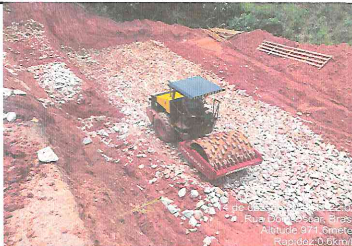
EXECUÇÃO DE ENROCAMENTO E COMPACTAÇÃO - MG - 383 / ALTO MARANHÃO
