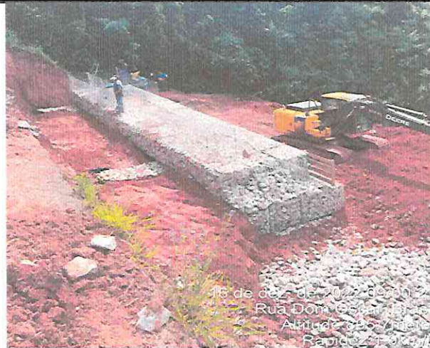
EXECUÇÃO DE MONTAGEM DE CAIXA DE GABIÃO E MANTA GEOTEXTIL - MG - 383 / ALTO MARANHÃO
