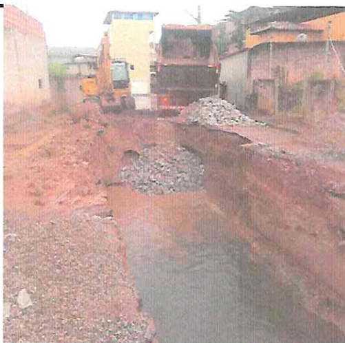
EXECUÇÃO DE ENROCAMENTO - RUA ALFREDO GUERRA - PRAIA
