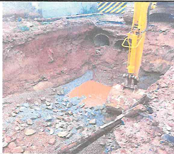
EXECUÇÃO DE ESCAVAÇÃO - RUA ALFREDO GUERRA - PRAIA
