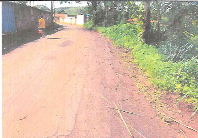
EXECUÇÃO DE LIMPEZA - RUA PRINCIPAL - BAIRRO IPIRANGA
