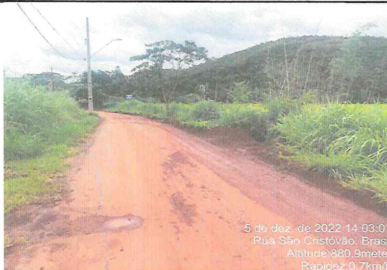
EXECUÇÃO DE LIMPEZA - RUA PRINCIPAL - BAIRRO IPIRANGA
