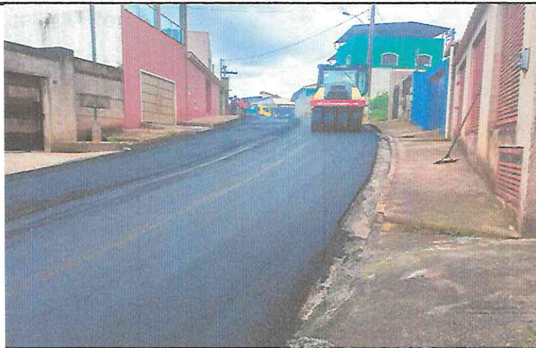
EXECUÇÃO DE CBUQ - BAIRRO CASA DE PEDRA
