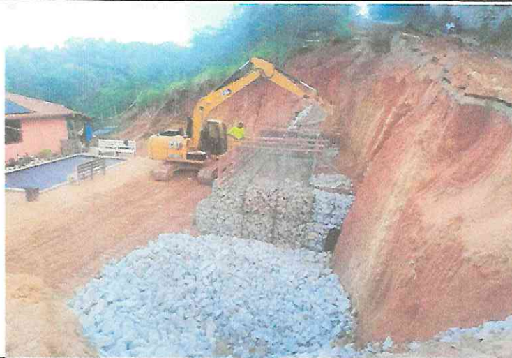
EXECUÇÃO DE GABIÃO-RUA ELZA TEREZINHA- RECANTO DAS ANDORINHAS
