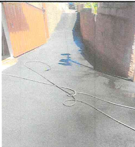
RECAPEAMENTO MANUAL - RUA DOM PEDRO I - CENTRO
