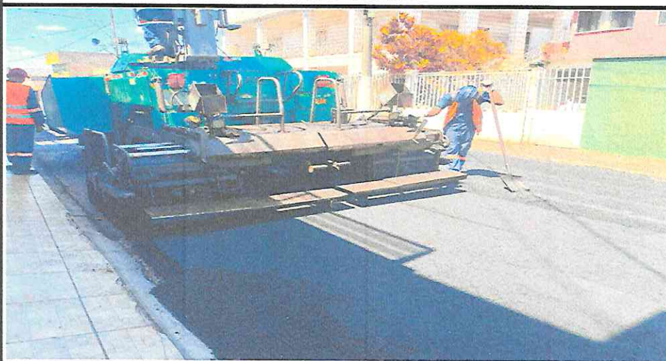
EXECUÇÃO DE CBUQ - RUA DJALMA BORGES - IDEAL
