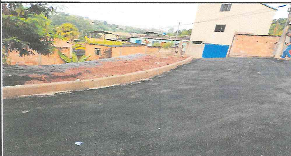
EXECUÇÃO DE CBUQ - RUA TEODOLINO JOSÉ DA SILVA - ALVORADA
