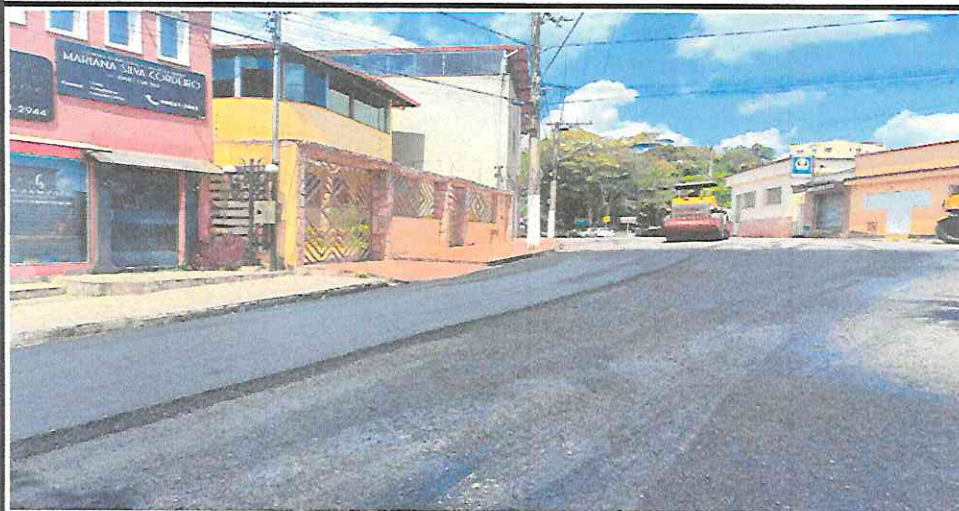
EXECUÇÃO DE CBUQ - RUA PAULO MENDES
