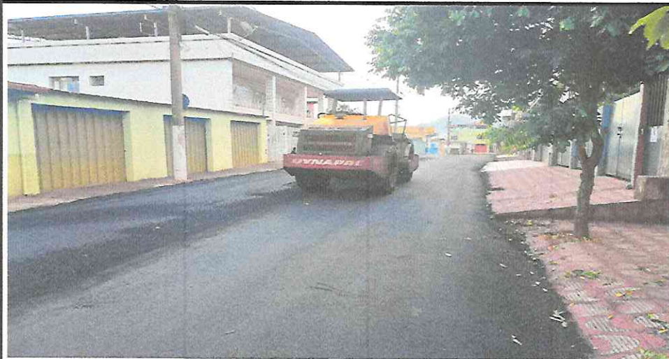
EXECUÇÃO DE CBUQ - RUA DJALMA BORGES - IDEAL
