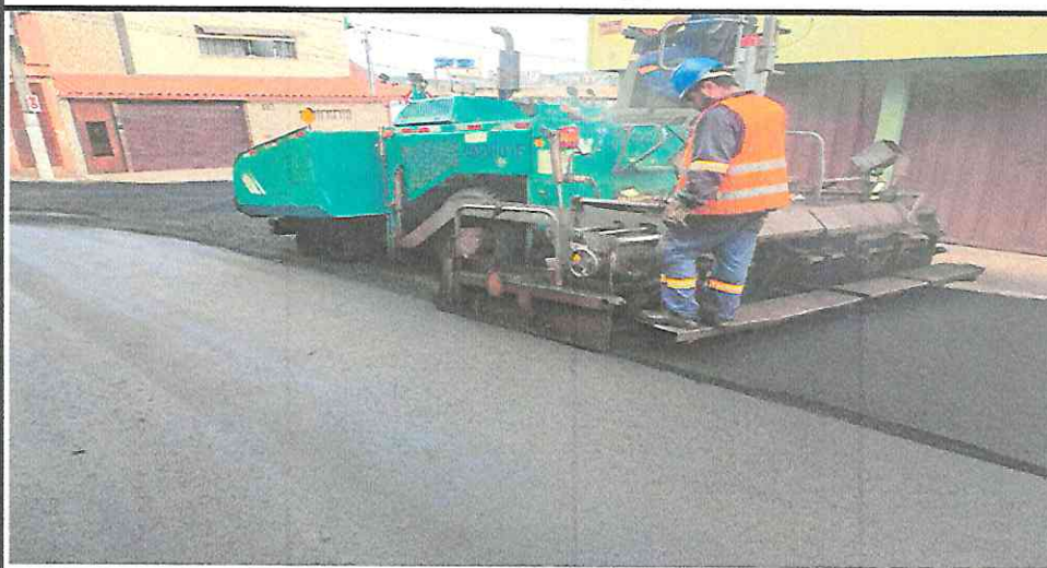
EXECUÇÃO DE CBUQ - RUA DJALMA BORGES - IDEAL
