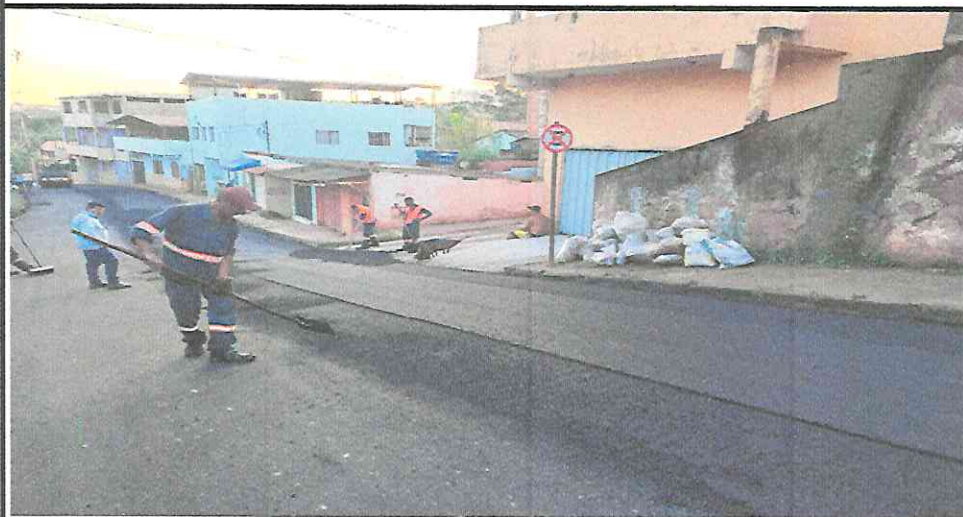
EXECUÇÃO DE CBUQ - RUA FRANCISCO MATEUS DE OLIVEIRA - PRAIA
