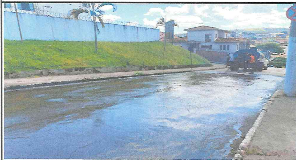
APLICAÇÃO DE PINTURA DE LIGAÇÃO - RUA PAULO MENDES (CENTRO)
