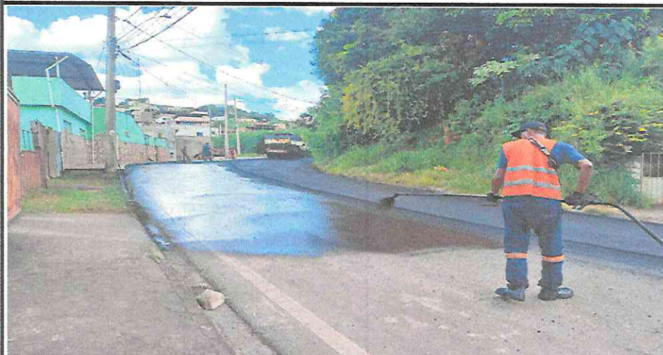
APLICAÇÃO DE PINTURA DE LIGAÇÃO - RUA FRANCISCO MATEUS DE OLIVEIRA - PRAIA
