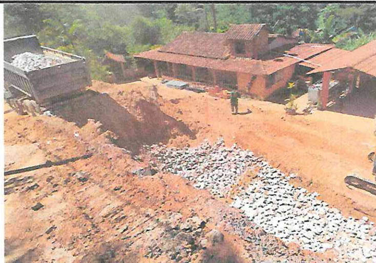
EXECUÇÃO DE ENROCAMENTO- RUA ELZA TEREZINHA- RECANTO DAS ANDORINHAS
