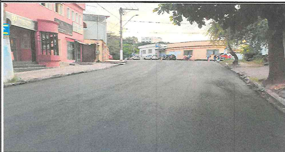
EXECUÇÃO DE CBUQ - RUA PAULO MENDES
