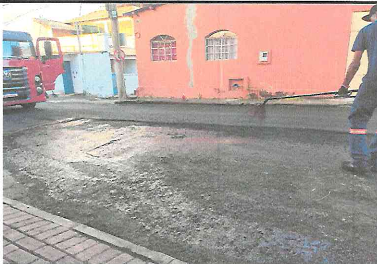
APLICAÇÃO DE PINTURA DE LIGAÇÃO - RUA DOM PEDRO I - CENTRO
