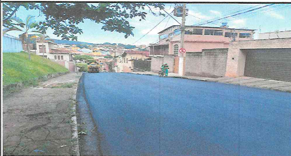
EXECUÇÃO DE CBUQ - RUA PAULO MENDES
