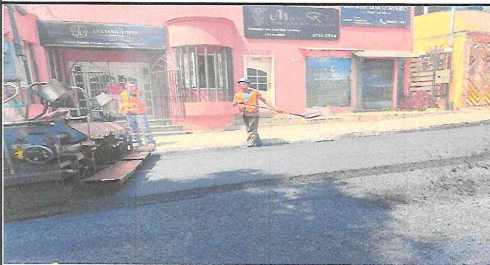
EXECUÇÃO DE CBUQ - RUA PAULO MENDES
