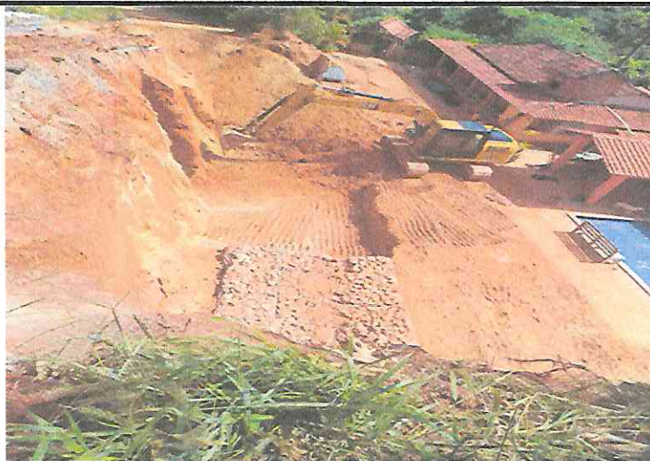
ESCAVAÇÃO- RUA ELZA TEREZINHA- RECANTO DAS ANDORINHAS
