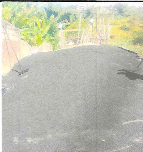
RECAPEAMENTO MANUAL - RUA DOM PEDRO I - CENTRO
