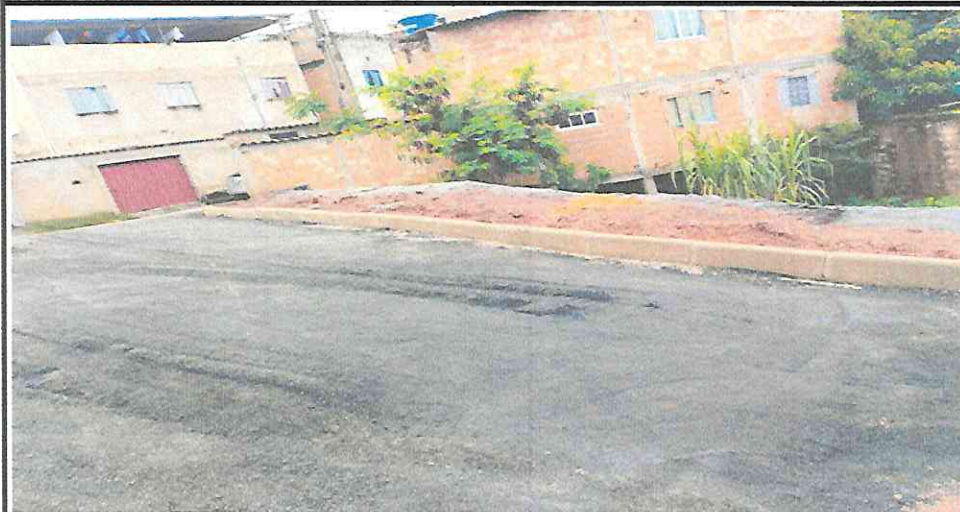
EXECUÇÃO DE CBUQ - RUA TEODOLINO JOSÉ DA SILVA - ALVORADA
