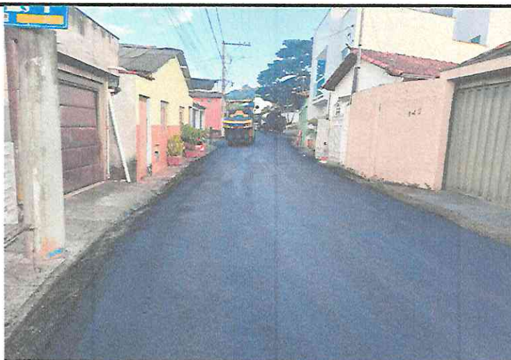
APLICAÇÃO DE CBUQ - RUA DOM PEDRO I - CENTRO
