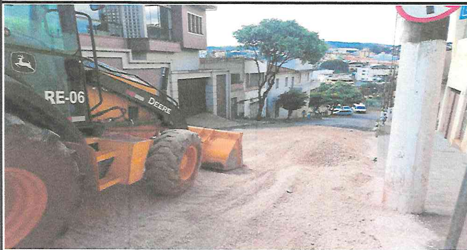
EXECUÇÃO DE BASE - RUA PAULO MENDES (CENTRO)
