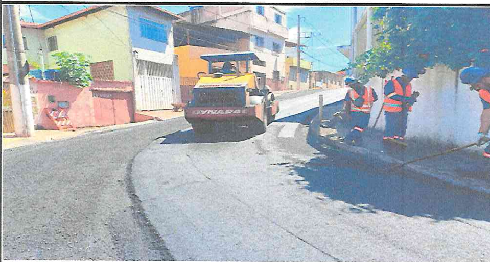
EXECUÇÃO DE CBUQ - RUA DJALMA BORGES - IDEAL
