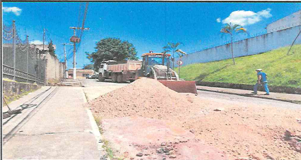
EXECUÇÃO DE BASE - RUA PAULO MENDES (CENTRO)
