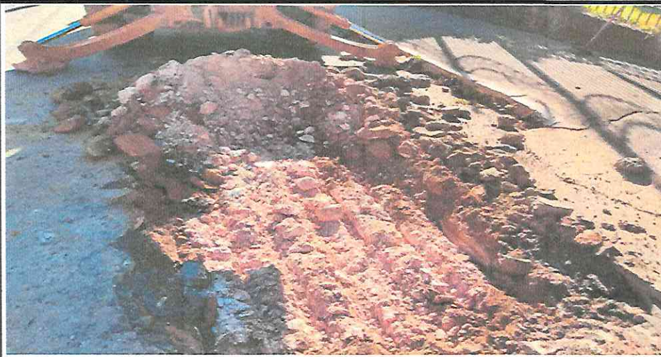
DEMOLIÇÃO DE CBUQ - RUA PAULO MENDES (CENTRO)
