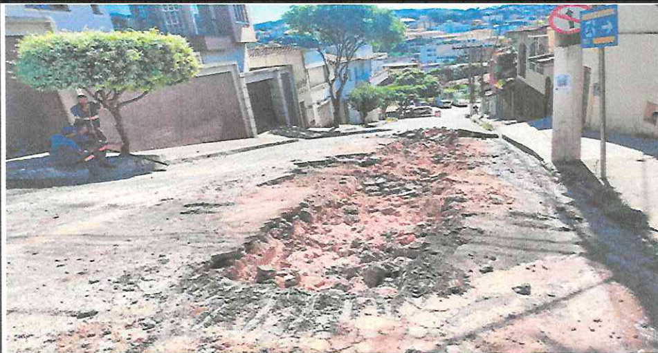
DEMOLIÇÃO DE CBUQ - RUA PAULO MENDES (CENTRO)
