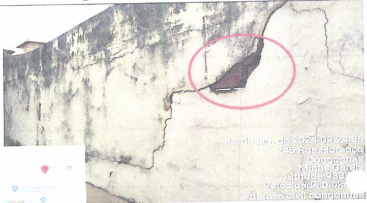
Figura 22: Rachaduras no muro, lateral direita.
