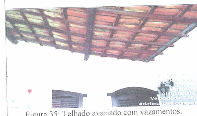
Figura 35: Telhado avariado com vazamentos.
