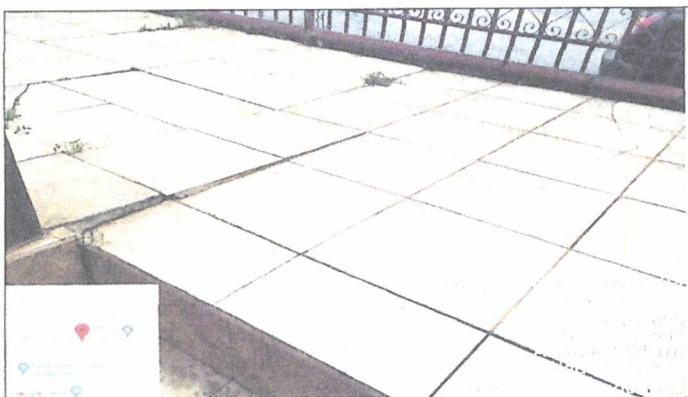
Figura 07: Afundamento do piso - pátio externo
