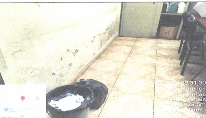
Figura 13: Avarias na parede advindo de umidade
