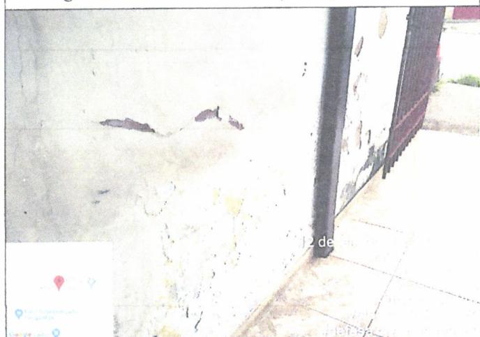
Figura 11: Avarias na parede advindo de umidade
