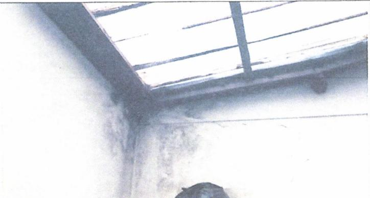
Figura 14: Marcas de infiltração
