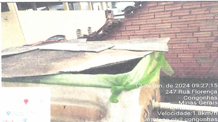
Figura 16: Caixas d'água de amianto com avarias
