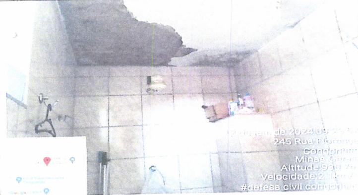
Figura 24: Deslocamento reboco da laje (banheiro - subsolo)
