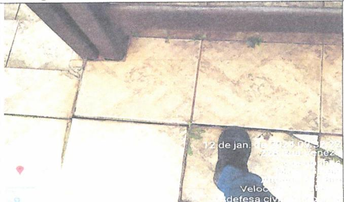
Figura 09: Afundamento do piso - pátio externo
