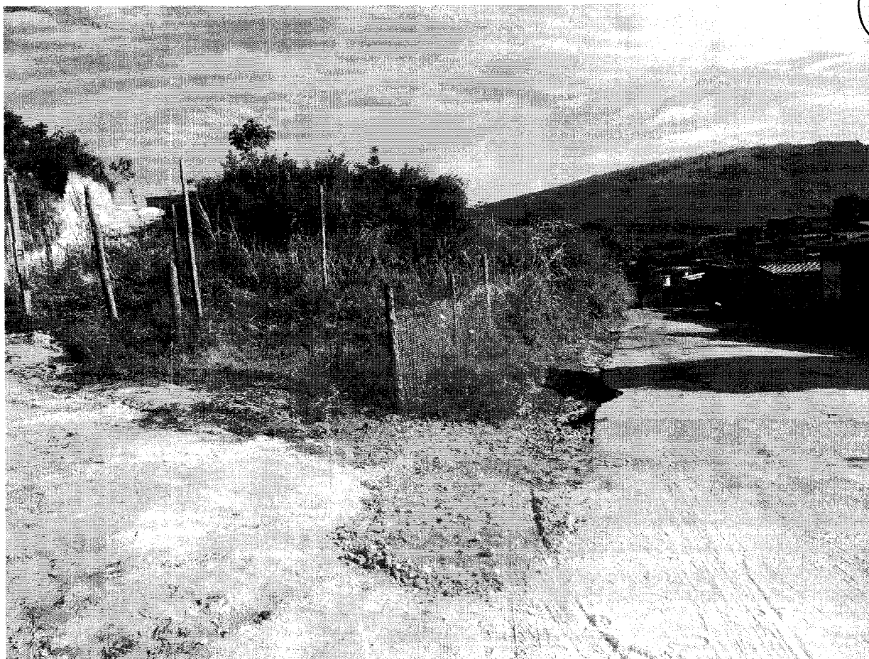
Imagem 7: Acesso 02 pela Rua Arlindo Morais Faustino - Datada de 10/05/2016
