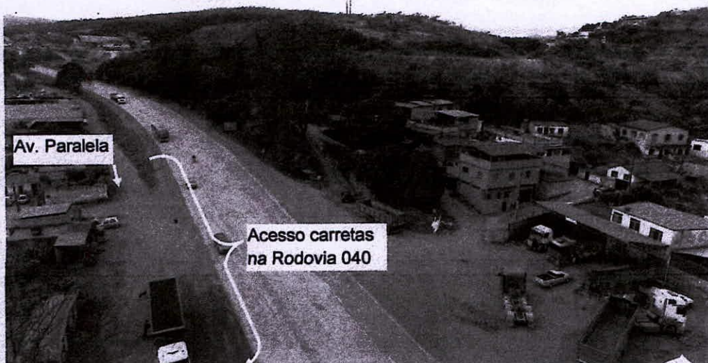
Foto 01- Faixa de acesso a Rodovia BR040, ao final da Av. Paralela – Bairro Vila conde.
