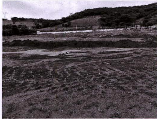
Foto 04 – ponto de desague do sistema de drenagem direto do rio e remoção da mata
