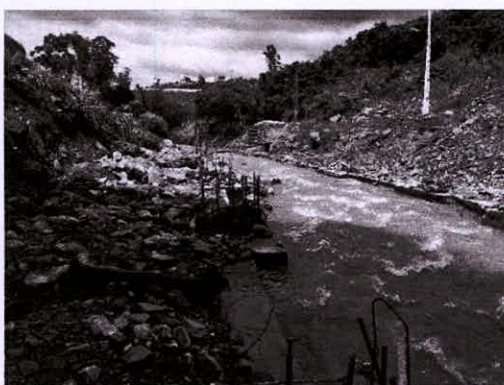
Foto 05 – Solo composto de rochas soltas e de difícil compactação, ter atenção
