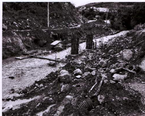
Foto 04 – Visão da cabeceira da ponte onde deve construir uma proteção para agua não entrar por traz dos muros de gabião
