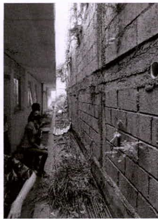
Foto 06 – Construção do fundo da clínica, muito próximo de muro com inclinação sobre a mesma.
