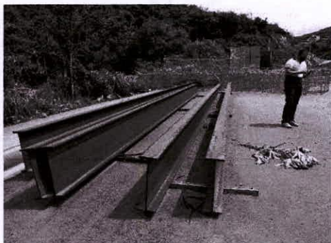
Foto 06 - Material de utilização na ponte depositado no canteiro e sem proteção com ação do tempo
