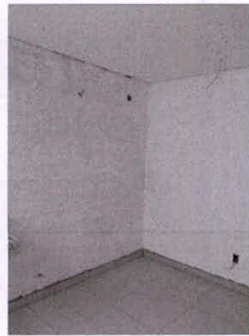
Foto 04 – Pé direito baixo, limita a circulação de ar e sensação de claustrofobia
