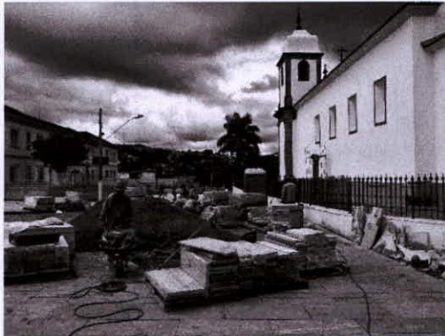
Foto 05 – Instalação de proteção sobre o solo que já está preparado para receber os bloquetes
