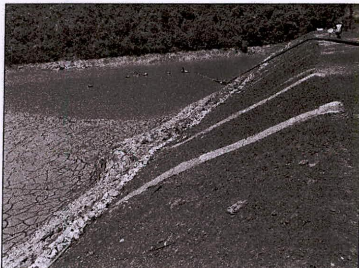
Foto 55 – Talude de montante do dique. Detalhe para a presença de canaletas de drenagem e faixa de proteção de rip-rap .
