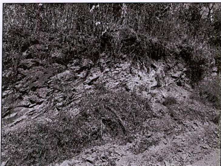
Foto 7 – Saprólito de filito em um corte de acesso para o dreno de fundo da estrutura, ombreira direita.
