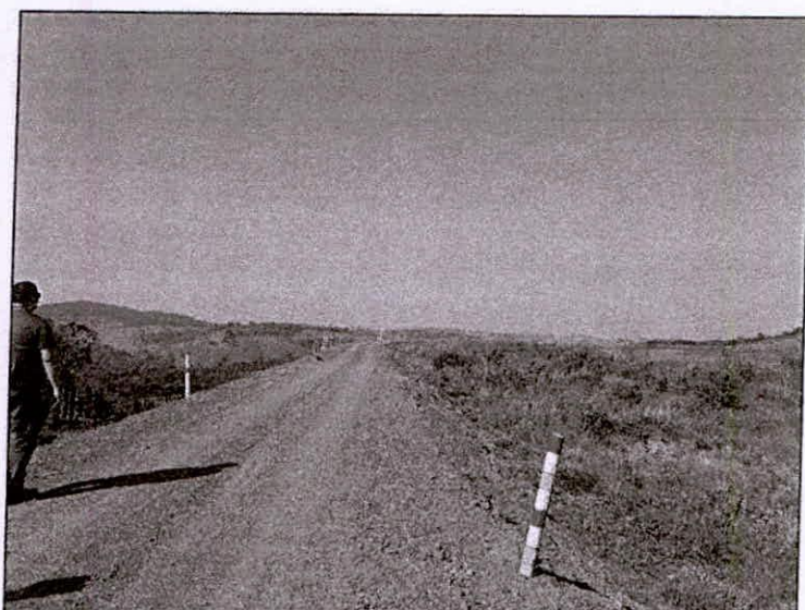
Foto 4 – Vista da crista a partir da ombreira esquerda.
