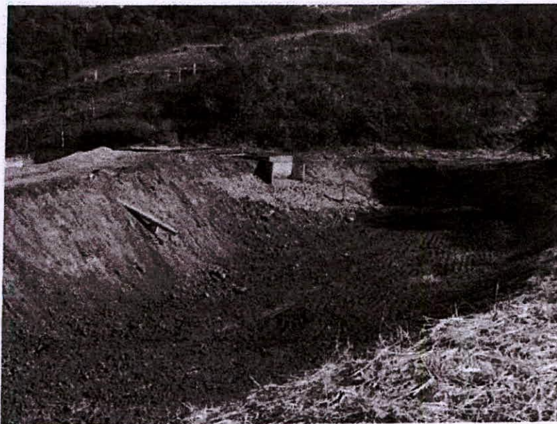
Foto 1: Reservatório, talude de montante e vertedor.
