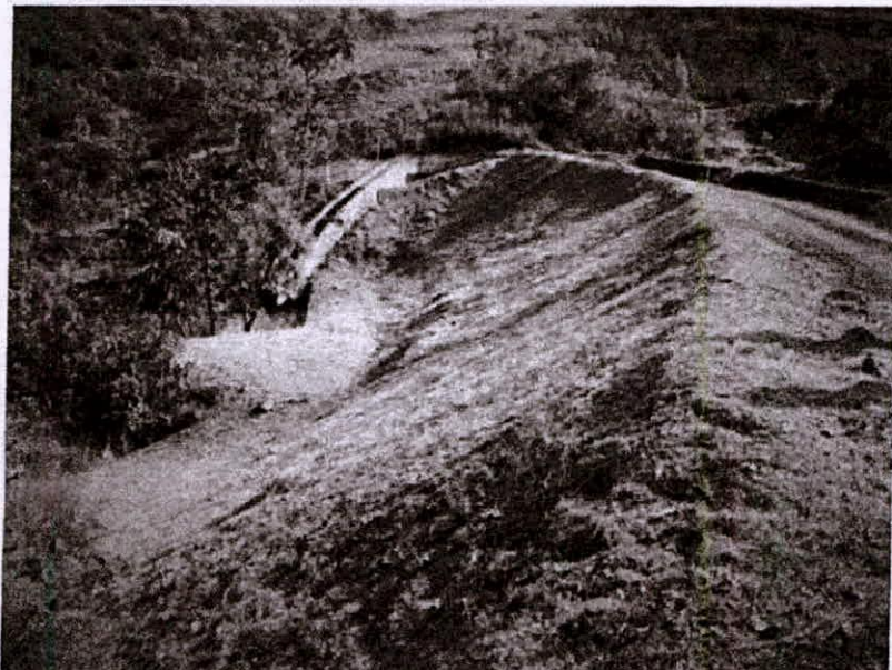
Foto 3: Talude de jusante.
