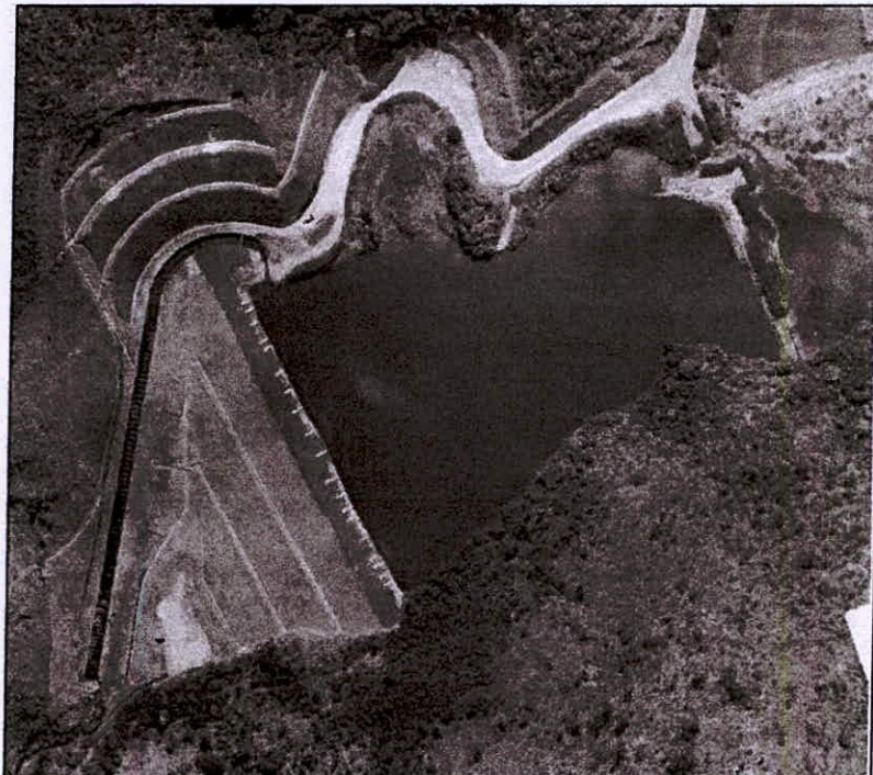
Figura 56 – Vista do reservatório e do talude montante do Dique do Esmeril IV.
