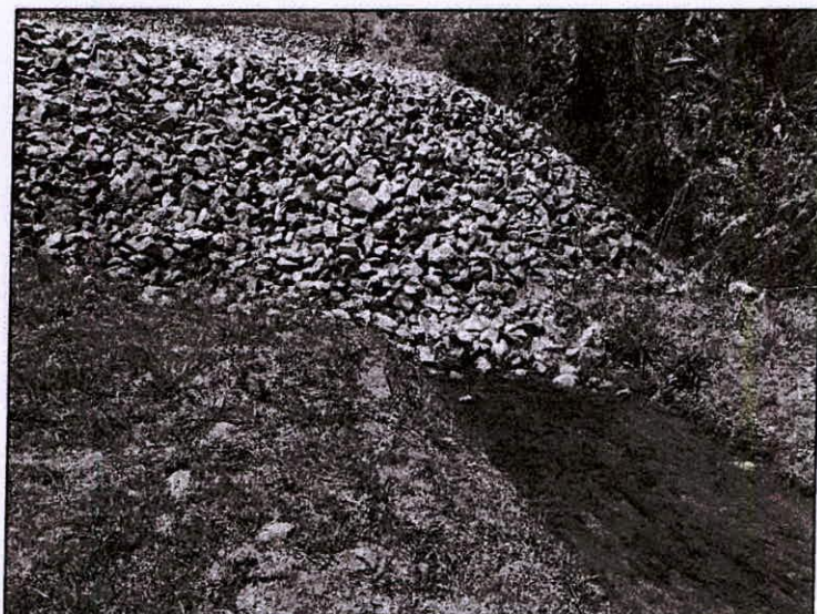
Foto 68 – Vista da saída do dreno de fundo.
