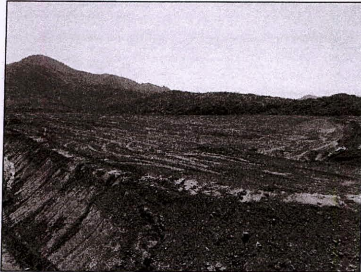
Foto 47 – Vista do reservatório a partir da ombreira direita.
