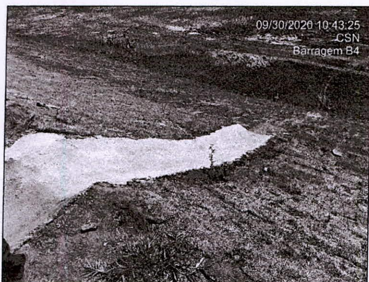
Foto 44 – Descida d'água no talude de montante.
