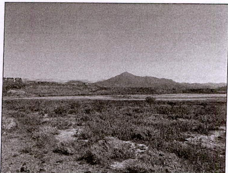
Foto 2 – Vista do reservatório da barragem de Casa de Pedra a partir da ombreira direita.
