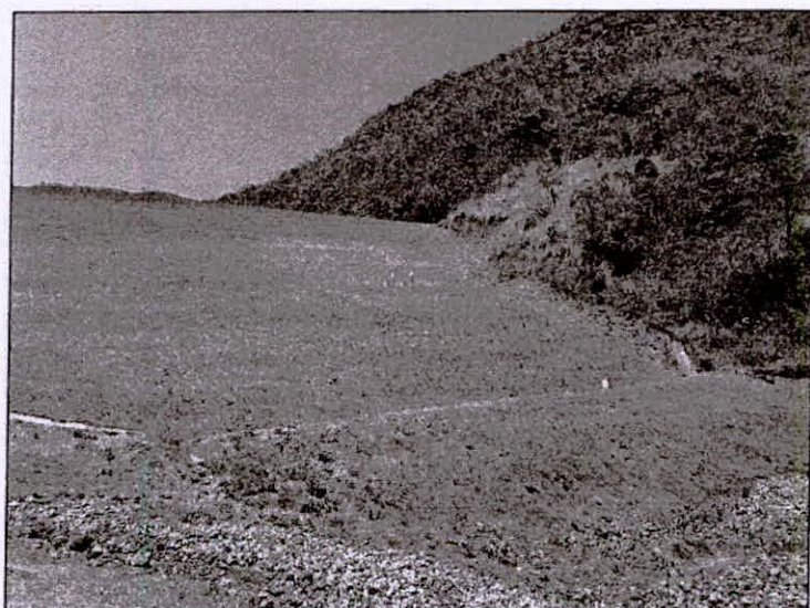
Foto 59 – Vista dos taludes de jusante inferiores, próximos à saída do dreno de fundo.
