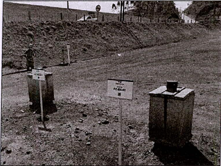
Foto 33 – Detalhe da instrumentação presente na estrutura.
