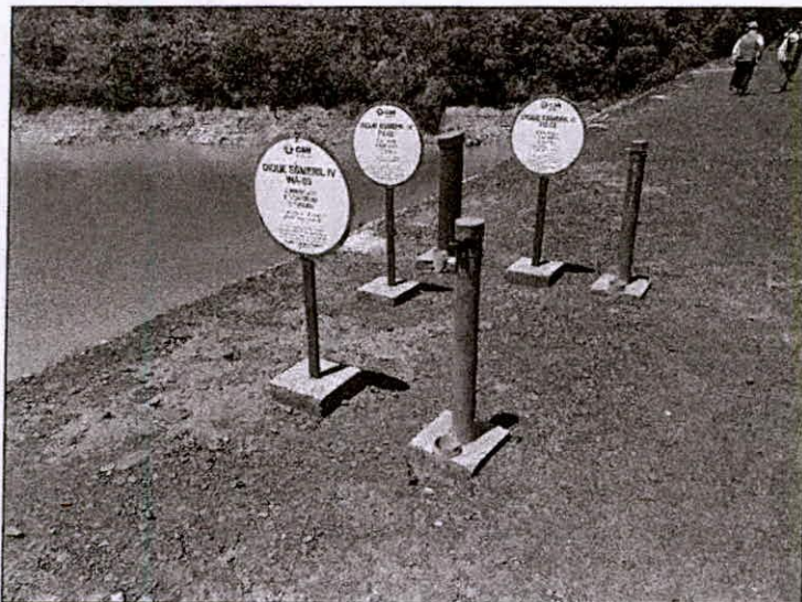
Foto 67 – Detalhe da instrumentação existente na estrutura.
