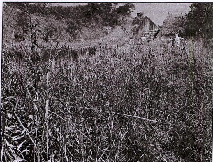
Foto 19 – Região adjacente ao canal extravasor, com vegetação alta, não permitindo o acesso até o trecho inicial.
