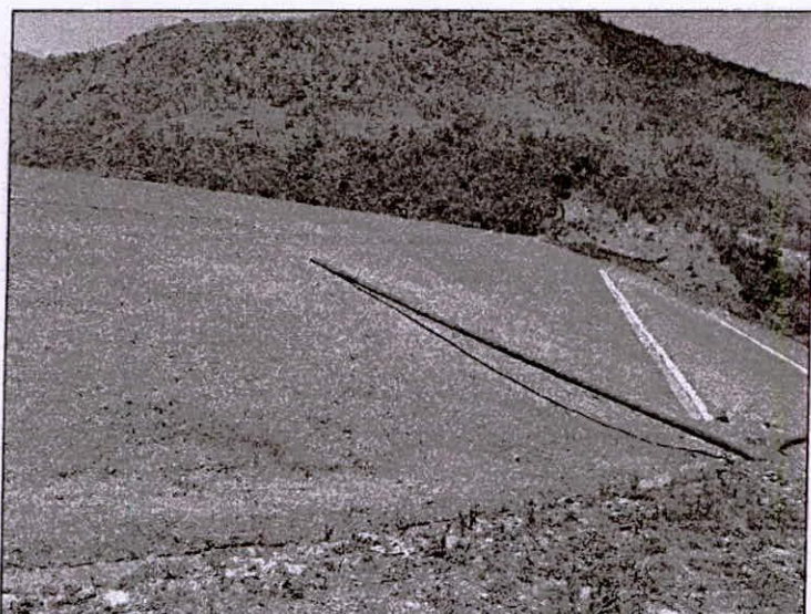
Foto 58 – Vista dos taludes de jusante superiores.
