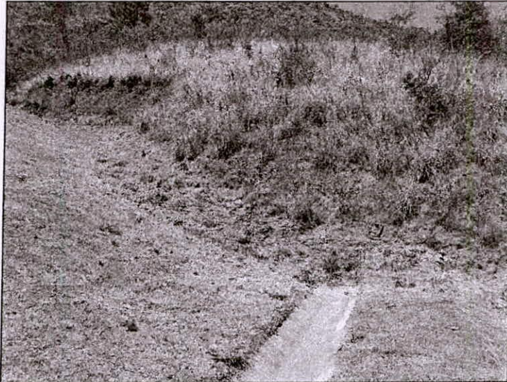
Foto 60 – Vista do encosto da estrutura com a ombreira esquerda, talude superior.
