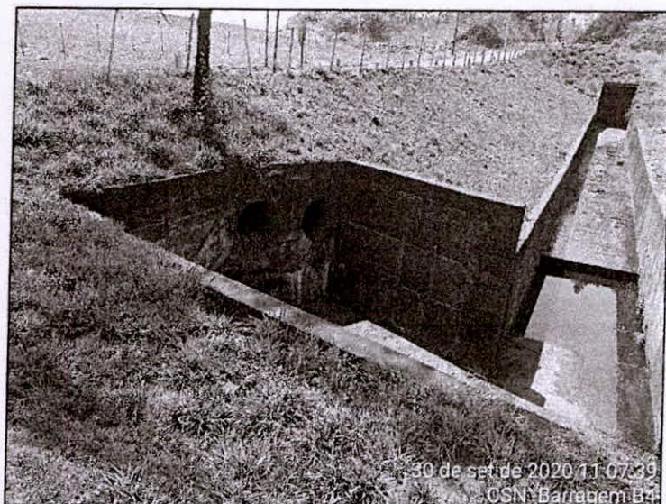
Foto 46 – Vista do desentupimento da drenagem superficial, no canal extravasor.
