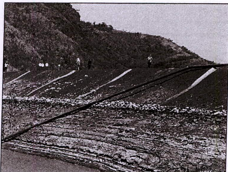
Foto 74 – Vista das canaletas implantadas no talude de jusante.
