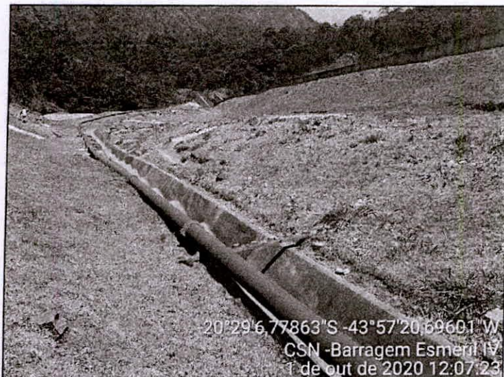
Foto 76 – Canaleta periférica, com degraus, na ombreira direita.
