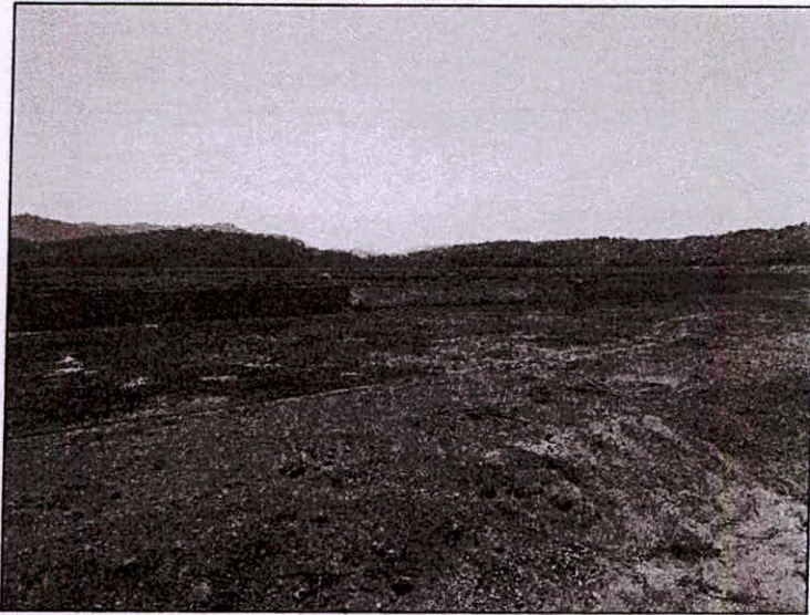
Foto 27 – Vista do reservatório a partir da crista.
