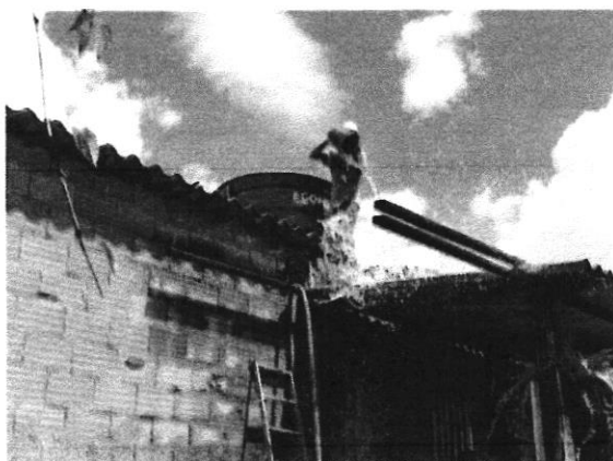
Figura 6 - Limpeza das caixas d'água.
