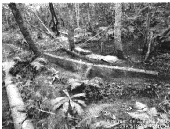
Figura 2 – Nascente que abastece a comunidade do Pires.
