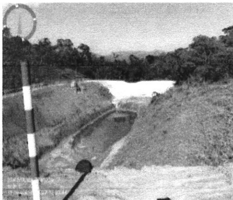
Figura 18 – Sump desassoreado, antes do início do período chuvoso.
