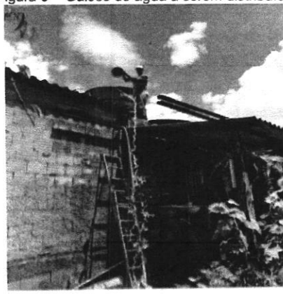
Figura 11 – Limpeza de caixas d'água.
