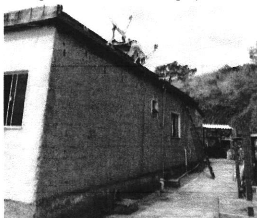
Figura 14 – Abastecimento de água potável.
