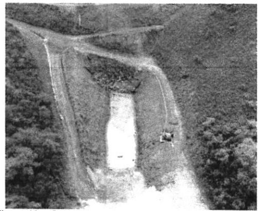
Figura 19 – Sump desassoreado, antes do início do período chuvoso.
