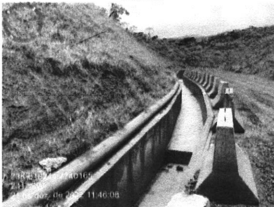
Figura 20 – Estruturas de drenagem implantadas.
