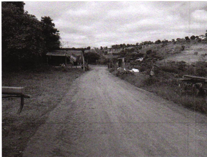
3) Infraestrutura com abertura de acesso, limpeza,:
