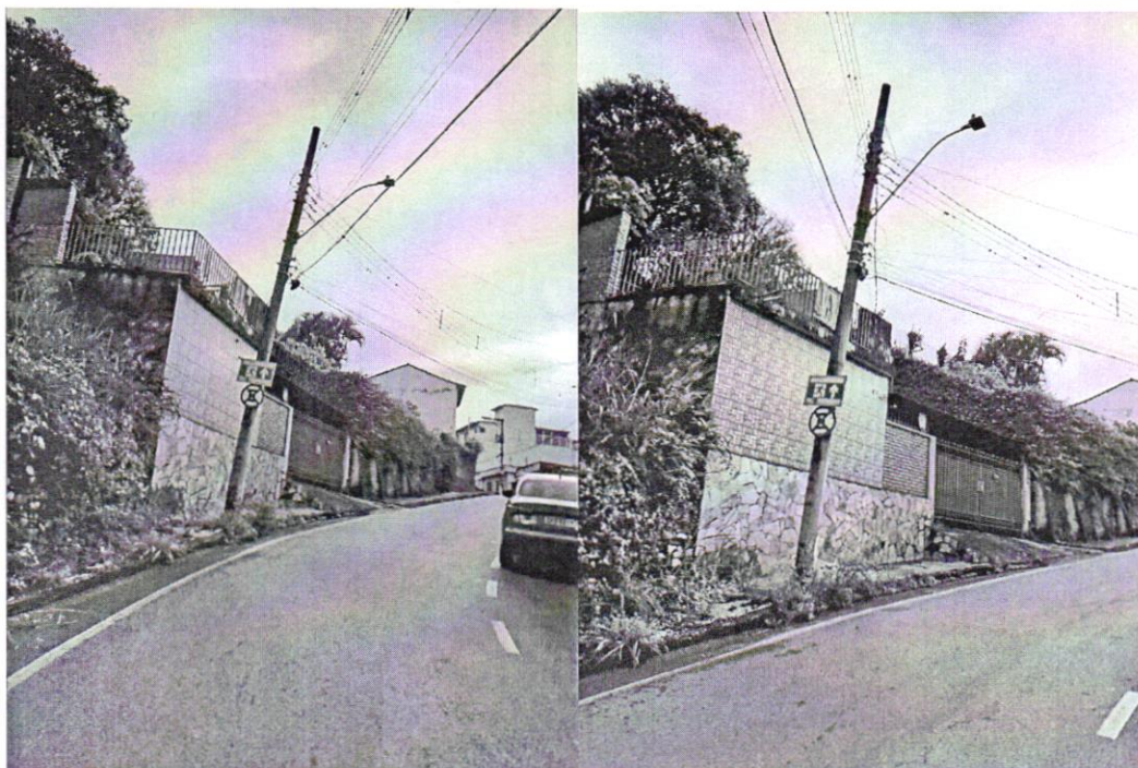
Poste na Rua do Ouro nº 165, Bairro Praia
