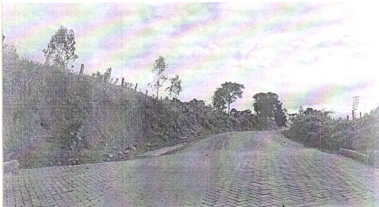
1. Conclusão das obras de pavimentação com blocos intertravados na estrada de acesso à localidade Castanheira
