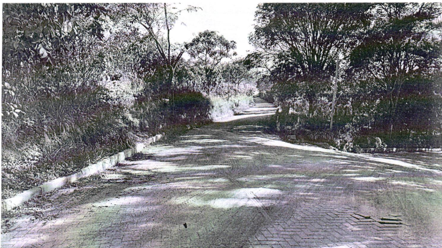
4. Conclusão da pavimentação em blocos intertravados
