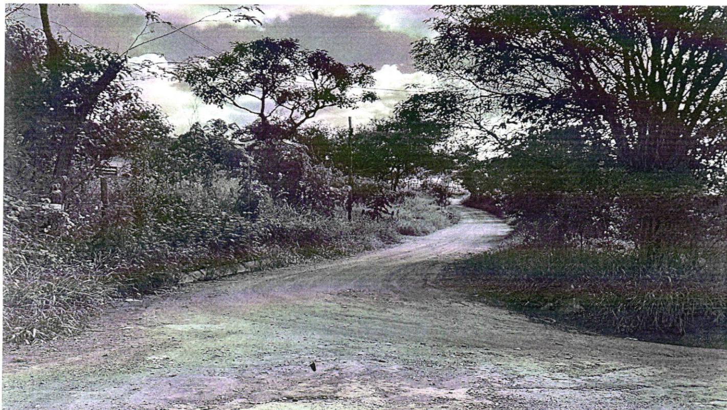
8 e 9. Implantação de sistema de drenagem pluvial e meios-fios
