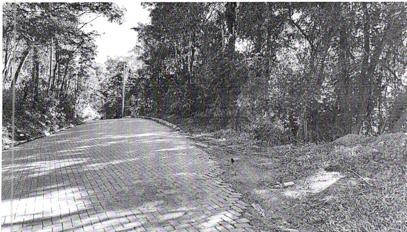
3. Instalação de lixeira tipo contêiner 500 litros - (Local 01)
