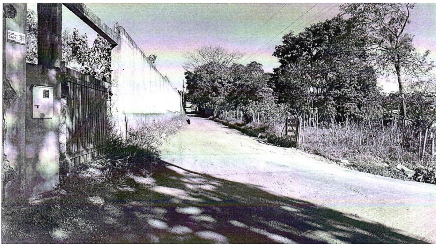
8 e 9. Implantação de sistema de drenagem pluvial e meios-fios
