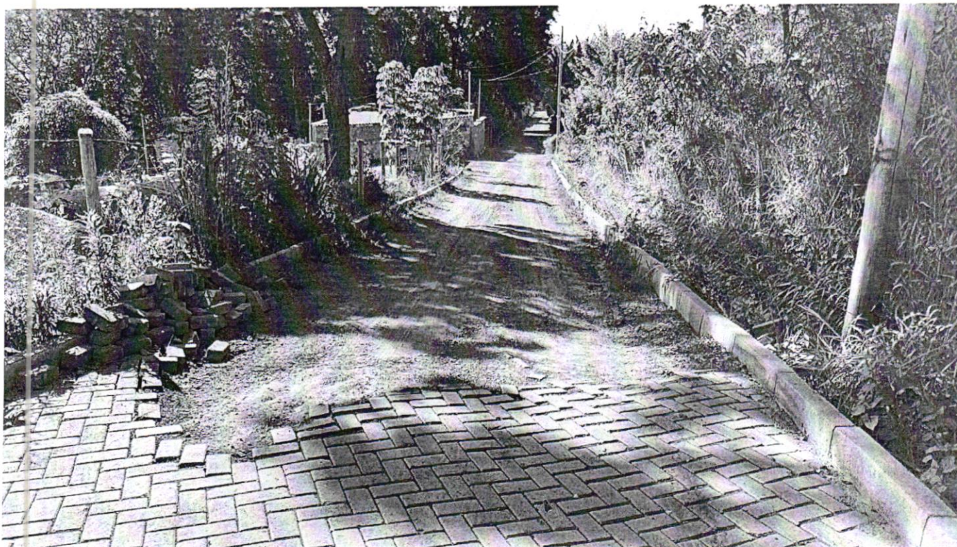
4. Conclusão da pavimentação em blocos intertravados
