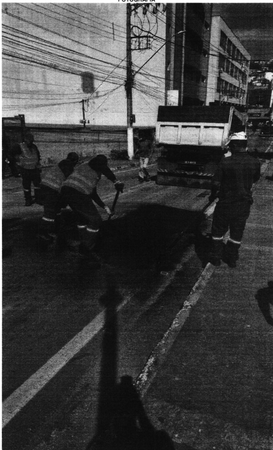
Revitalização de asfalto
