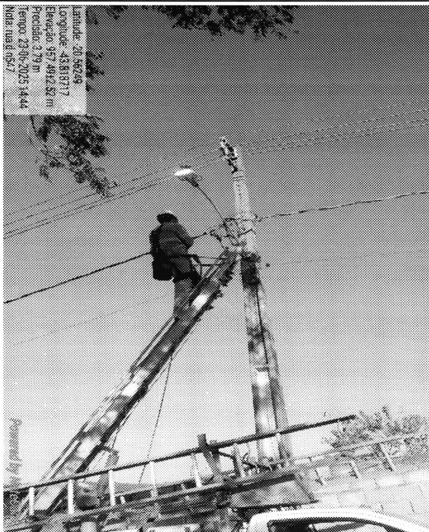
Manutenção de braço com luminária - Rua Luiz de Paula Pedro
