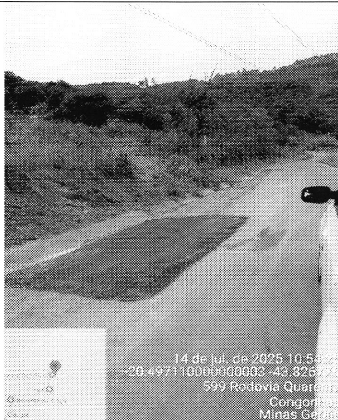
Recomposição da pavimentação asfáltica - Rua Raimundo Sabará
