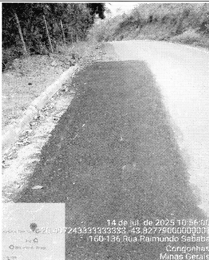
Recomposição da pavimentação asfáltica - Rua Raimundo Sabará
