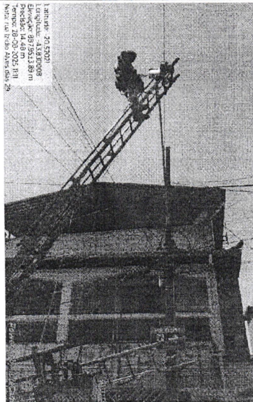
Manutenção de Iluminação Pública - rua Isídio Alves Dias, nº 29, bairro Jardim Profeta.
