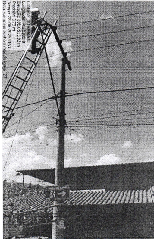
Manutenção de Iluminação Pública - rua Nossa Senhora Mãe da Igreja, nº 127, bairro Jardim Profeta.
