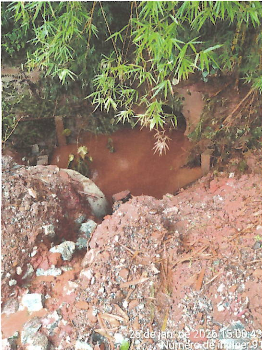
Foto 01 e 02 – Vista do efluente/curso d'água, com forte coloração na saída da manilha abaixo da ferrovia (ponto 1).
