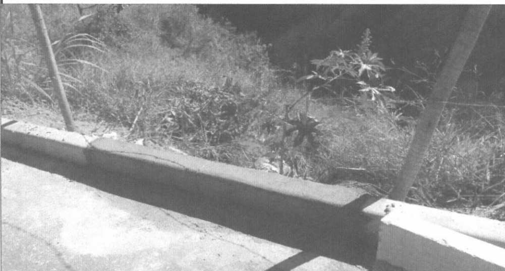
EXECUÇÃO DE CONTENÇÃO EM CONCRETO (ITEM 01) - ÁGUA BOA (RUA 10)
