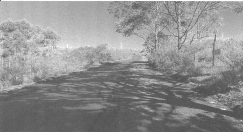
EXECUÇÃO DE CBUQ - ÁREA 9 (RUA 8 P/ PREFEITURA) - ÁGUA BOA)
