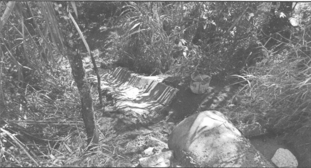
SAÍDA D'ÁGUA EM BOCA DE MANILHA EM CONCRETO - ÁGUA BOA (RUA 10)
