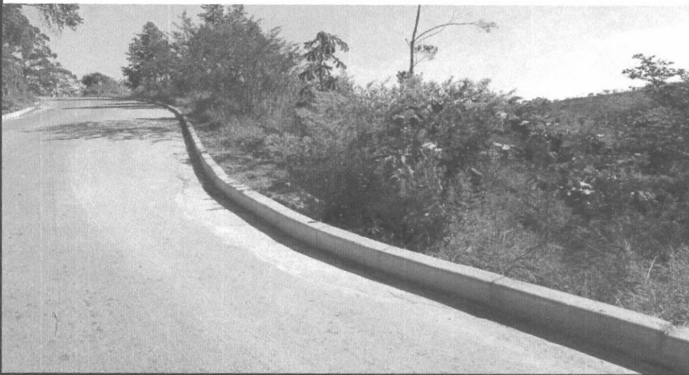
EXECUÇÃO DE CONTENÇÃO EM CONCRETO (ITEM 03) - ÁGUA BOA (RUA 10)
