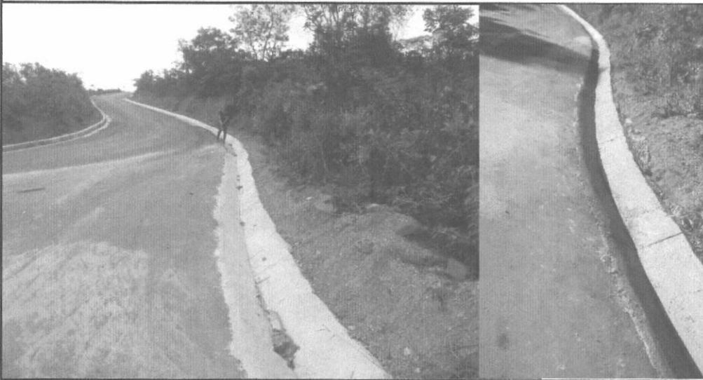
EXECUÇÃO DE SARJETA TRIANGULAR - ÁGUA BOA (RUA 11 - SUBINDO LD)
