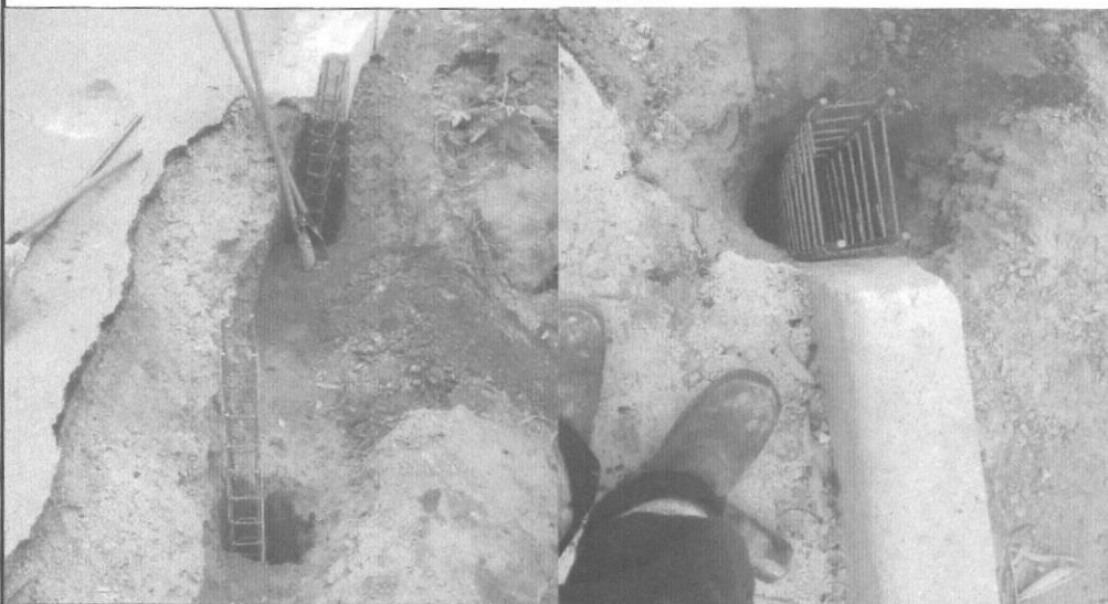
ARMAÇÃO PARA CONTENÇÃO (MEIO FIO IN LOCO) - ÁGUA BOA (RUA 10)
