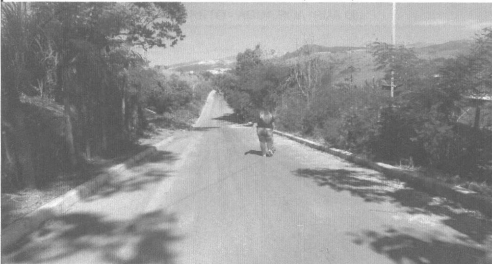
EXECUÇÃO / ASSENTAMENTO DE MEIO FIO COM CONFINAMENTO EM CONCRETO - ÁGUA BOA (RUA 01)
