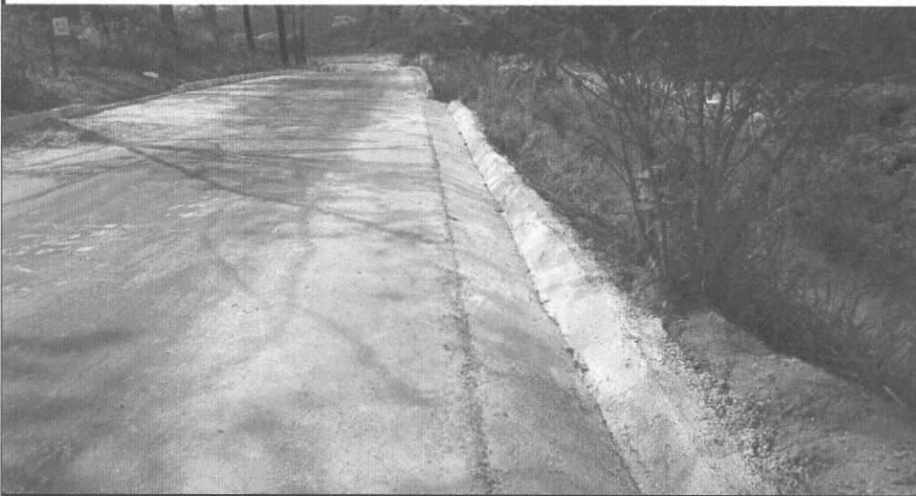
EXECUÇÃO DE SARJETA EM "V" - ÁREA 9 (RUA 8 P/ PREFEITURA) - ÁGUA BOA
