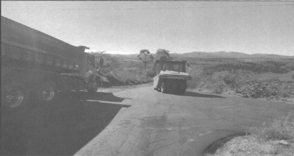
EXECUÇÃO DE CBUQ - ÁREA 9 (RUA 8 P/ PREFEITURA) - ÁGUA BOA)
