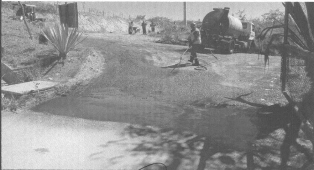
EXECUÇÃO DE IMPRIMAÇÃO - ÁREA 9 (RUA 8 P/ PREFEITURA) - ÁGUA BOA)
