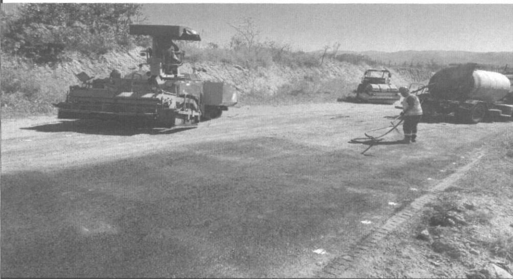
EXECUÇÃO DE PINTURA DE LIGAÇÃO - ÁREA 9 (RUA 8 P/ PREFEITURA) - ÁGUA BOA)
