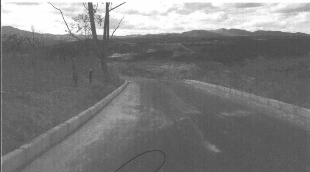
ASSENTAMENTO DE MEIO FIO - ÁREA 9 (RUA 8 P/ PREFEITURA) - ÁGUA BOA)
