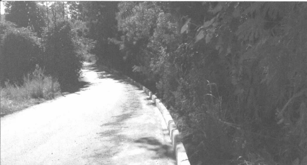
EXECUÇÃO / ASSENTAMENTO DE MEIO FIO COM CONFINAMENTO EM CONCRETO - ÁGUA BOA (RUA 10 - ENTRADA)
