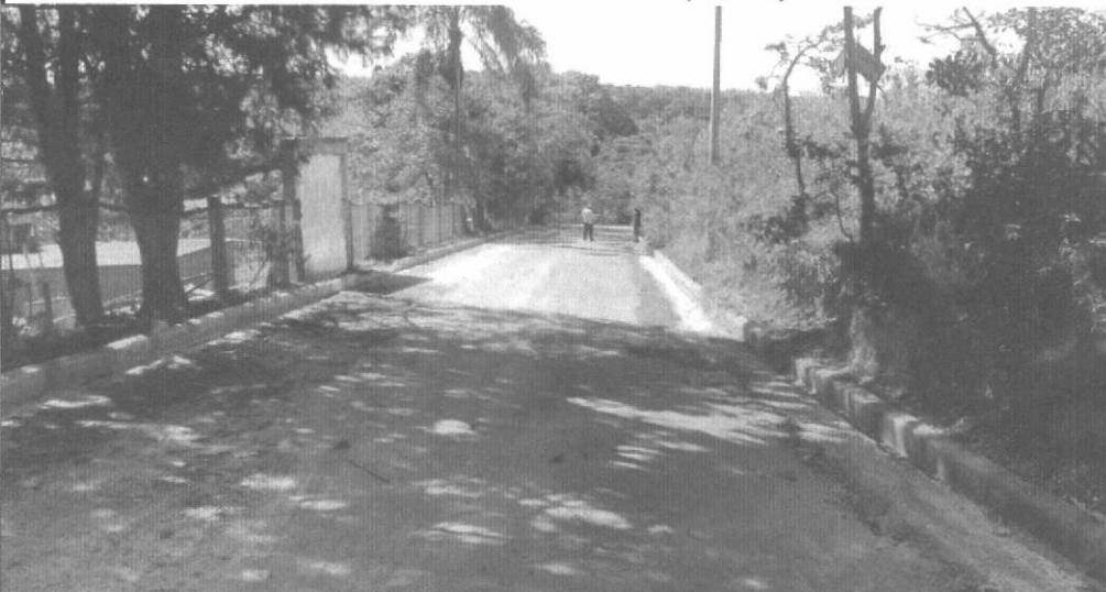
EXECUÇÃO / ASSENTAMENTO DE MEIO FIO COM CONFINAMENTO EM CONCRETO - ÁGUA BOA (RUA 2)
