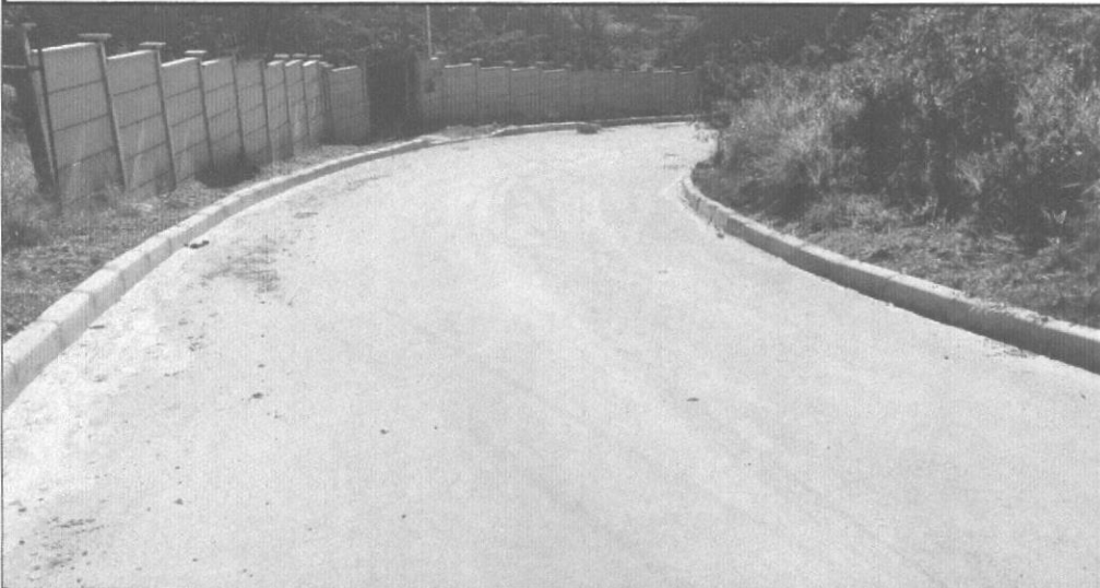
EXECUÇÃO / ASSENTAMENTO DE MEIO FIO COM CONFINAMENTO EM CONCRETO - ÁGUA BOA (RUA 8)
