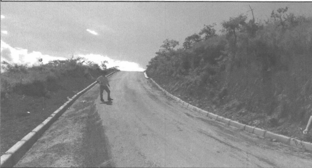
EXECUÇÃO / ASSENTAMENTO DE MEIO FIO COM CONFINAMENTO EM CONCRETO - ÁGUA BOA (RUA 08)
