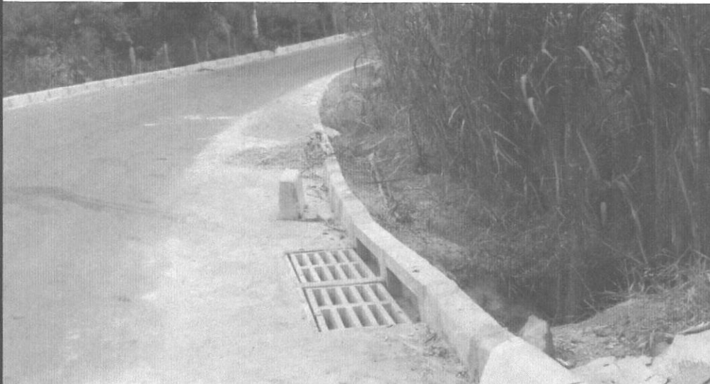
EXECUÇÃO DE BOCA DE LOBO DUPLA - ÁGUA BOA (RUA 10 - PRÓXIMO A PONTE)
