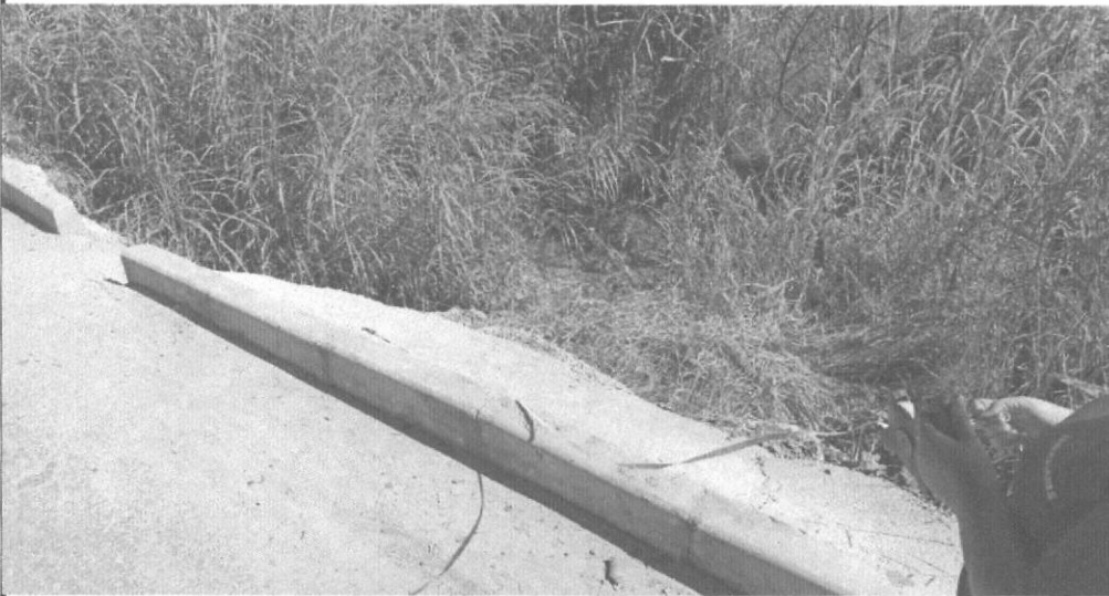
CONCRETO PARA CONTENÇÃO DE MEIO FIO - ÁGUA BOA (RUA 10)
