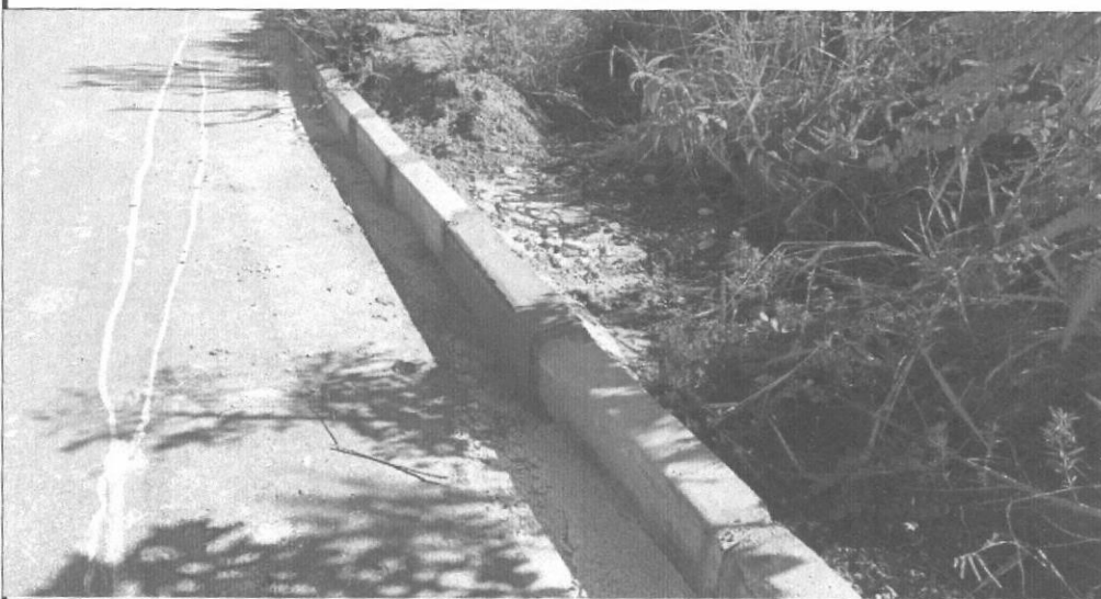
EXECUÇÃO DE CONTENÇÃO EM CONCRETO (ITEM 02) - ÁGUA BOA (RUA 10)
