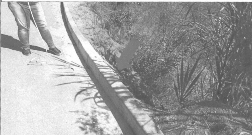
EXECUÇÃO DE CONTENÇÃO EM CONCRETO (ITEM 04) - ÁGUA BOA (RUA 10)
