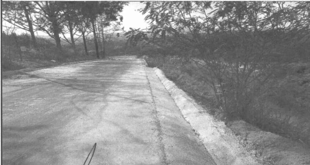
EXECUÇÃO DE SARJETA EM "V" - ÁREA 9 (RUA 8 P/ PREFEITURA) - ÁGUA BOA
